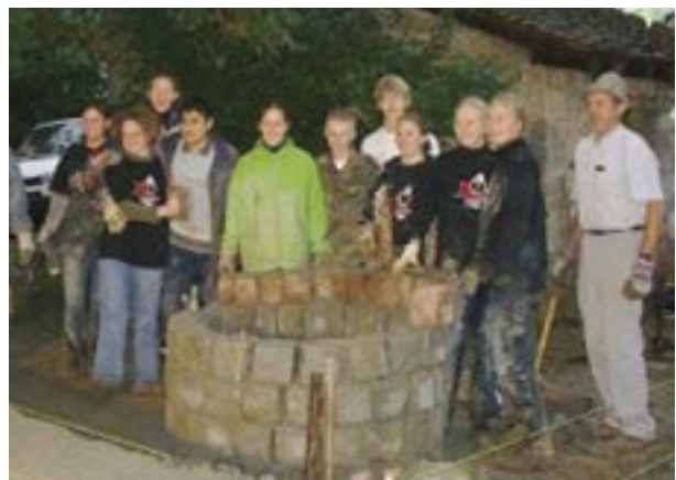
MinistrantInnen aus Weinstadt bei der Sanierung an der Wallfahrtskapelle „Käpelle“
